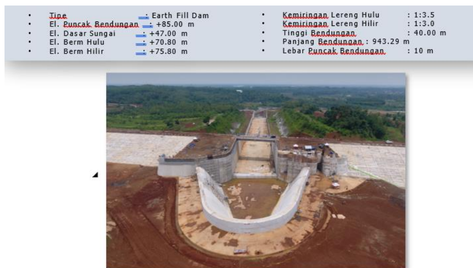
Gambar 1. Photo Udara proses pekerjaan Bendungan Sadawarna
