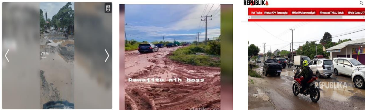
Gambar 3 Kondisi memprihatinkan jalanan di Lampung Sumber: Data diolah penulis berdasarkan rujukan kepustakaan
